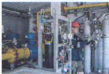
Ремонт предусматривал полную замену оборудования станции
